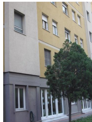
Figura 4.1 - Particolare della porzione di involucro della facciata Nord. In evidenza la differenza di finitura fra Piano Terra e Piani superiori
