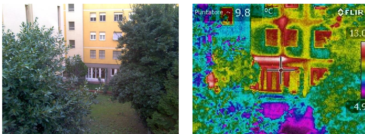
Figura 4.3 – Rilievo termografico della parete Nord
