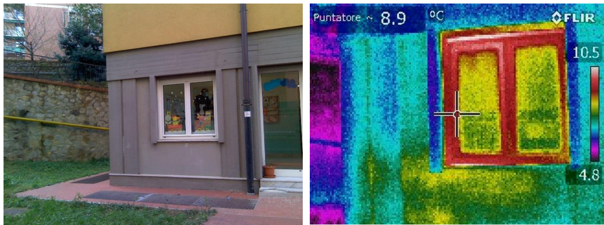
Figura 4.6 – Rilievo termografico dei serramenti sulla facciata Nord
