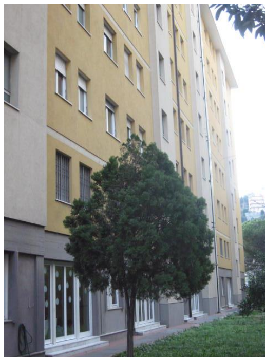
Figura 1.1 - Vista della facciata esposta a Nord
