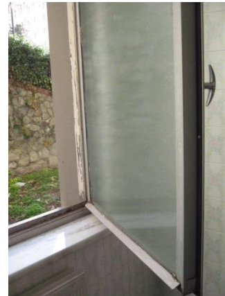
Figura 4.5 - Particolare dei serramenti Piano Seminterrato
